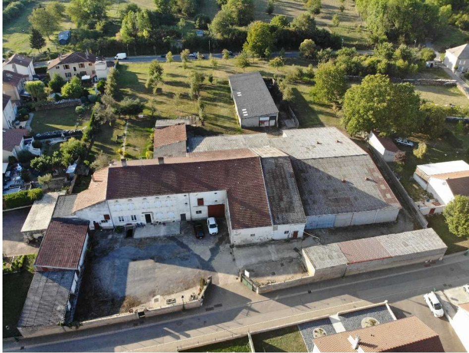
DOMAINE DU VERGER – VUE AVANT DEMOLITION
