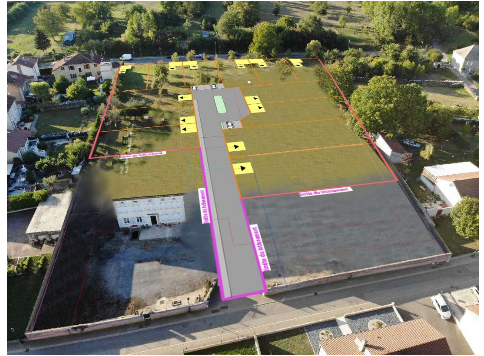
DOMAINE DU VERGER VUE IMPLANTATION PARCELLES APRES DEMOLITION
